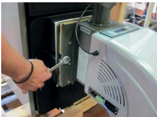
Fig. 25 Montage du brûleur
