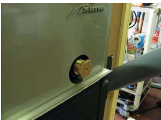
Fig. 27 Réduction en laiton
