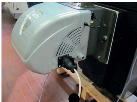
Fig. 33 Câble du moteur de la vis sans fin
