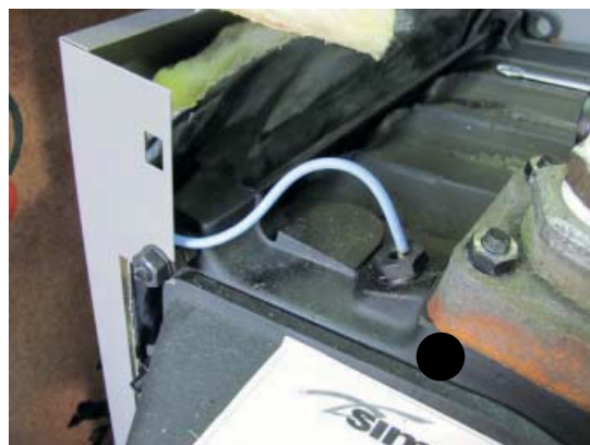
Fig. 36 Sonde de refoulement
