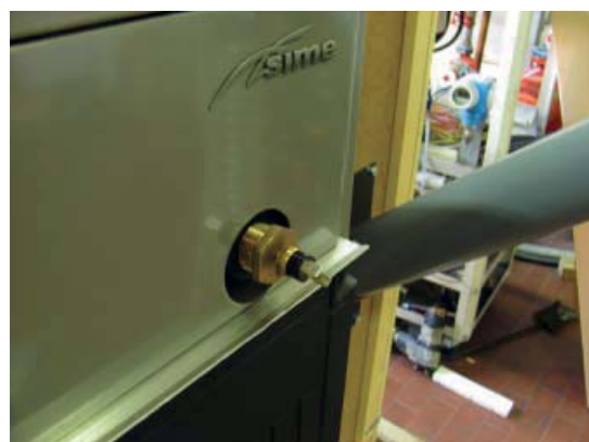
Fig. 28 Thermostat de sécurité
