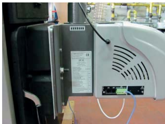
Fig. 26 Fixation du brûleur
